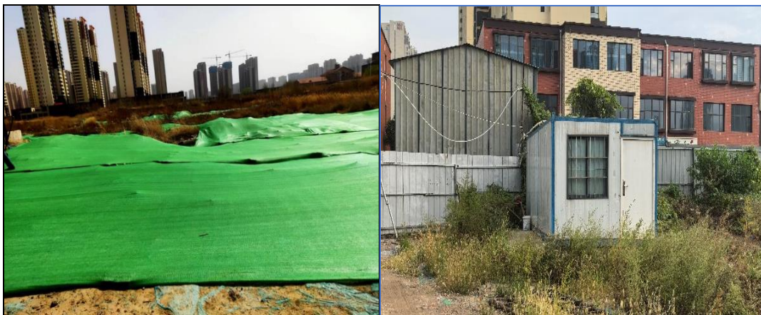
图 5 防尘苫盖以及管控人员工作岗位
