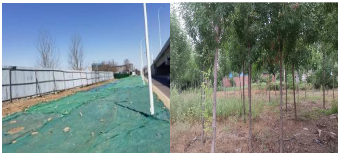
图 3 防尘苫盖及植被覆盖照片
